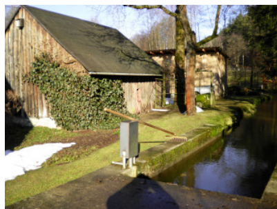
Wasseroberlauf zur Glasschleif
