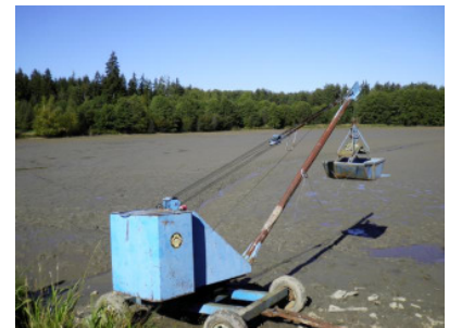
Ein Bagger beseitigt den Schlamm
