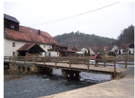
Holzbrücke und Mühle
