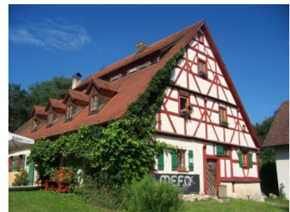
Fachwerk in Stöppach
