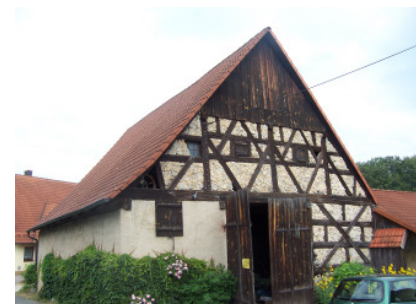
Alte Scheune in Hüll
